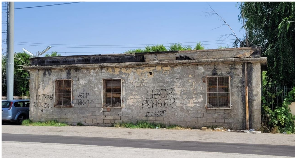
Figura 8. Un edificio abbandonato
