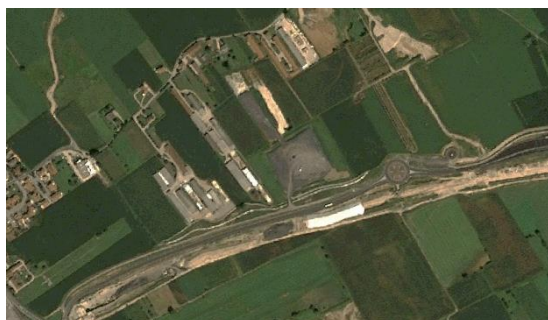
Figura 240. Cantieri stradali per la Pedemontana Veneta nel comune di Malo (VI)
