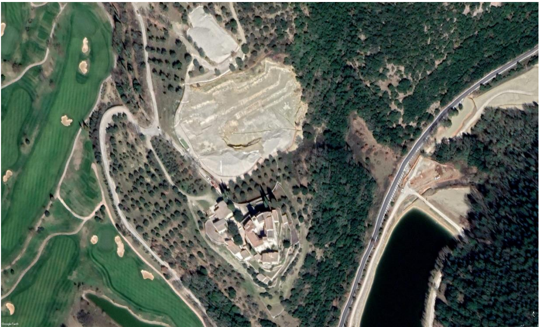
Figura 262. Borgo e Castello a cantiere avviato
