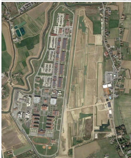
Figura 35. Cantiere di circa 30 ettari a Vicenza (immagini 2020 e 2021) per la realizzazione di un parco cittadino sull'area dell'ex aeroporto, a compensazione per la costruzione della vicina caserma militare americana
