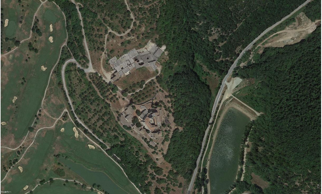
Figura 261. Borgo e Castello prima inizio lavori
